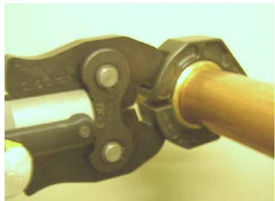
⑨継手がパイプにマーキング位置まで挿入されている事を確認する。プレス工具のスタートボタン(白色)を押し接合を開始する。接合は自動終了します。
