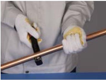
①パイプカッターでパイプを切断する。
