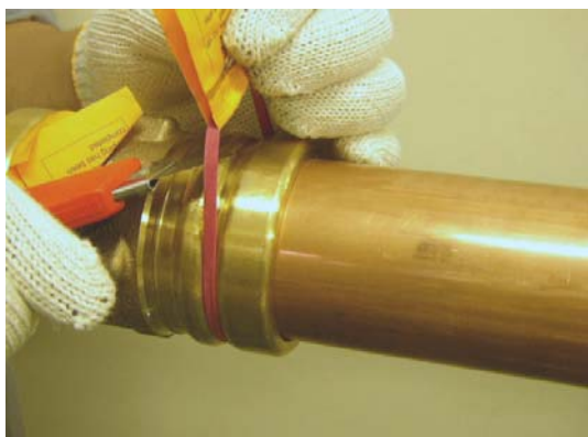
⑩接合終了後プレス工具の開放ボタン(黒色)を押し、締付治具を手動で開き、締付リングを取り外す。次にプレス作業終了確認リングを取り外す。作業完了
