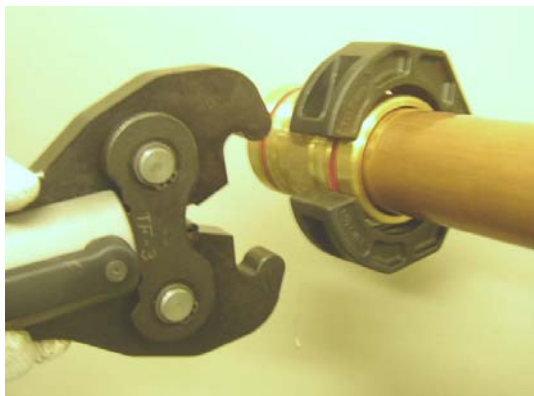
⑧プレス工具に締付治具(締付用リング専用)を取付け固定ボルトでセットし、次に締付治具先端を手動で開き、リング外側の固定箇所セットする。
