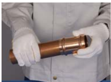
⑤継手をゆっくりスライドさせて最後止まるまでパイプに挿入する。
