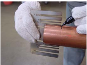
④接合深さをマーキングする。
