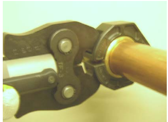
⑨継手がパイプにマーキング位置まで挿入されている事を確認する。プレス工具のスタートボタン(白色)を押し接合を開始する。接合は自動終了します。
