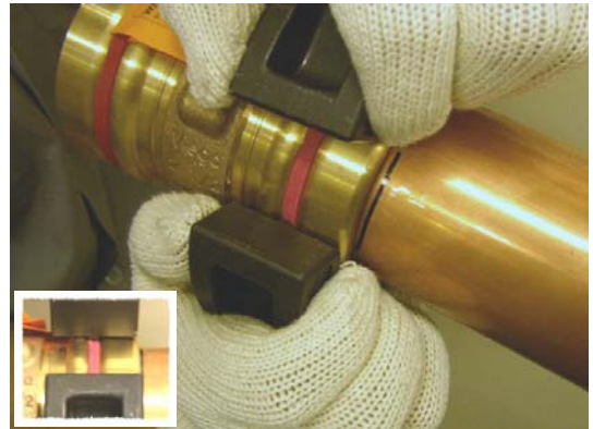
⑦締付用リングを継手の締付箇所である、へこみ位置に正確にセットする。この時、締付用リングの開き部分を手前(作業側)にセットする。
